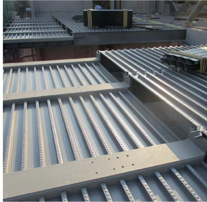
collaboranti HOLORB di Montana significava l'implementazione di appropriate connessioni antiincendio di sicurezza. Al tale scopo sono stati adottati raccordi a solaio a più strati con lo sviluppo di una propria soluzione antiincendio. Ciò ha richiesto la chiusura delle code di rondine aperte mediante l'impiego di riempitivi HILTI facili e rapidi da installare e che soddisfano pure i requisiti di isolamento acustico.
